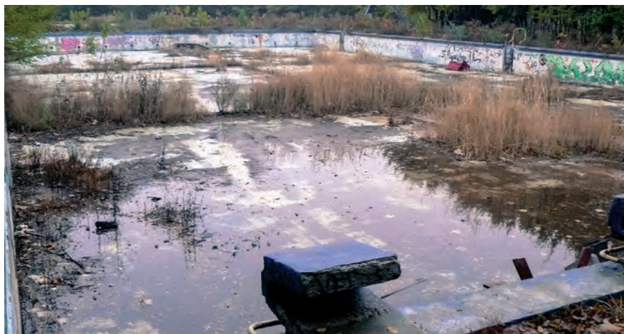
Zdewastowany basen, stan obecny. Źródło: GP
