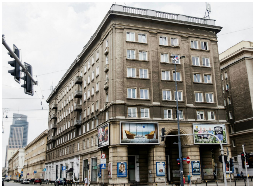
W tym miejscu kiedyś stała kamienica przy Solnej 1. Fot. RŚ
